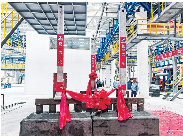
▲图为生产线投产现场。 田晓真 摄
